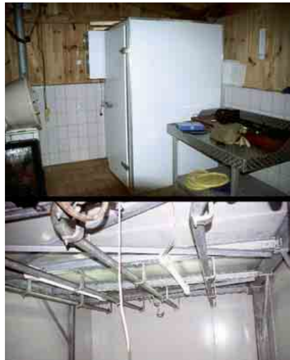
Bei größeren Stückzahlen sind begehbare Kühlzellen (o.) oder separate Kühlhäuser (u., mit Rohrbahnen) angebracht.
