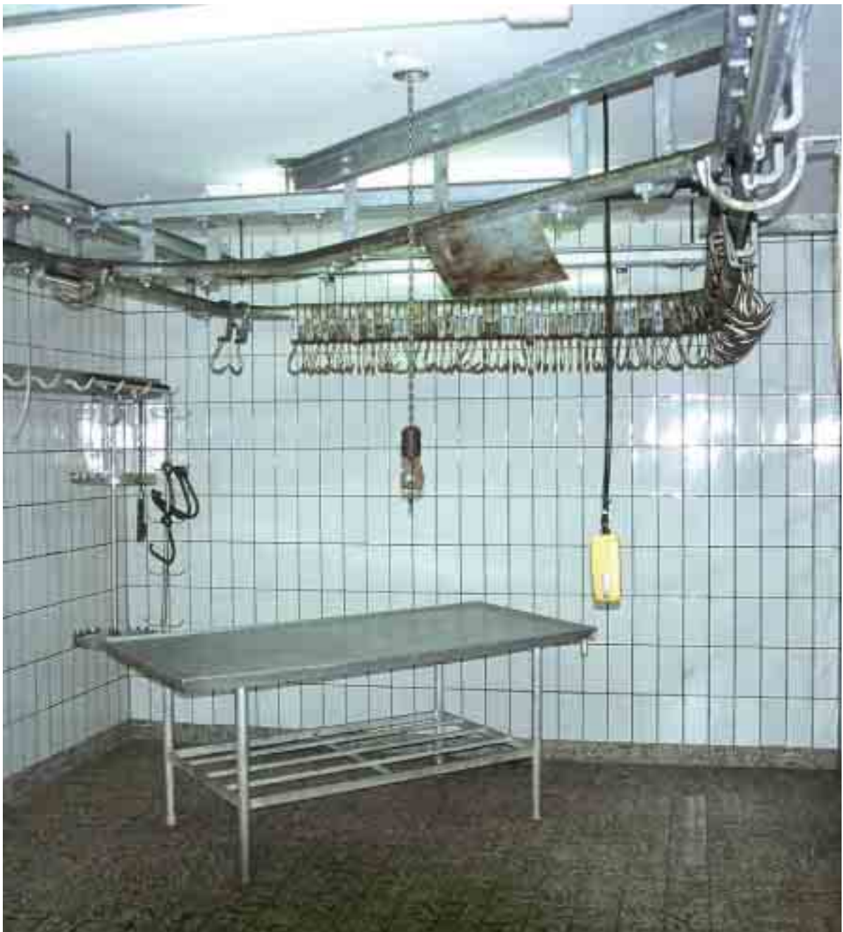
Mustergültige Wildkammer: Wände gefliest, die Decke entsprechend gestrichen – also hell, glatt und abwaschbar, Boden ebenfalls gefliest und damit „leicht zu reinigen“.
