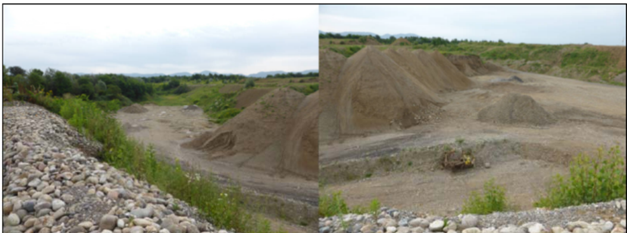
Blick auf den aufzufüllenden Bereich der DK I-Deponie
