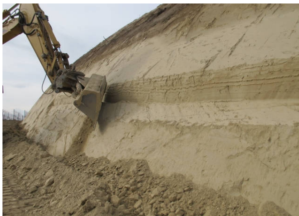
Erste Baggerarbeit durch seitliches Aufreißen – durch mehrmaliges Wiederholen kann der Löss-Absatz vertieft werden.
