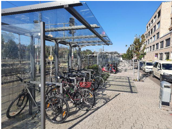
Abbildung 7-1: Beispiel für eine überdachte Fahrradabstellanlage mit Anlehnbügeln am Bahnhof Göppingen
