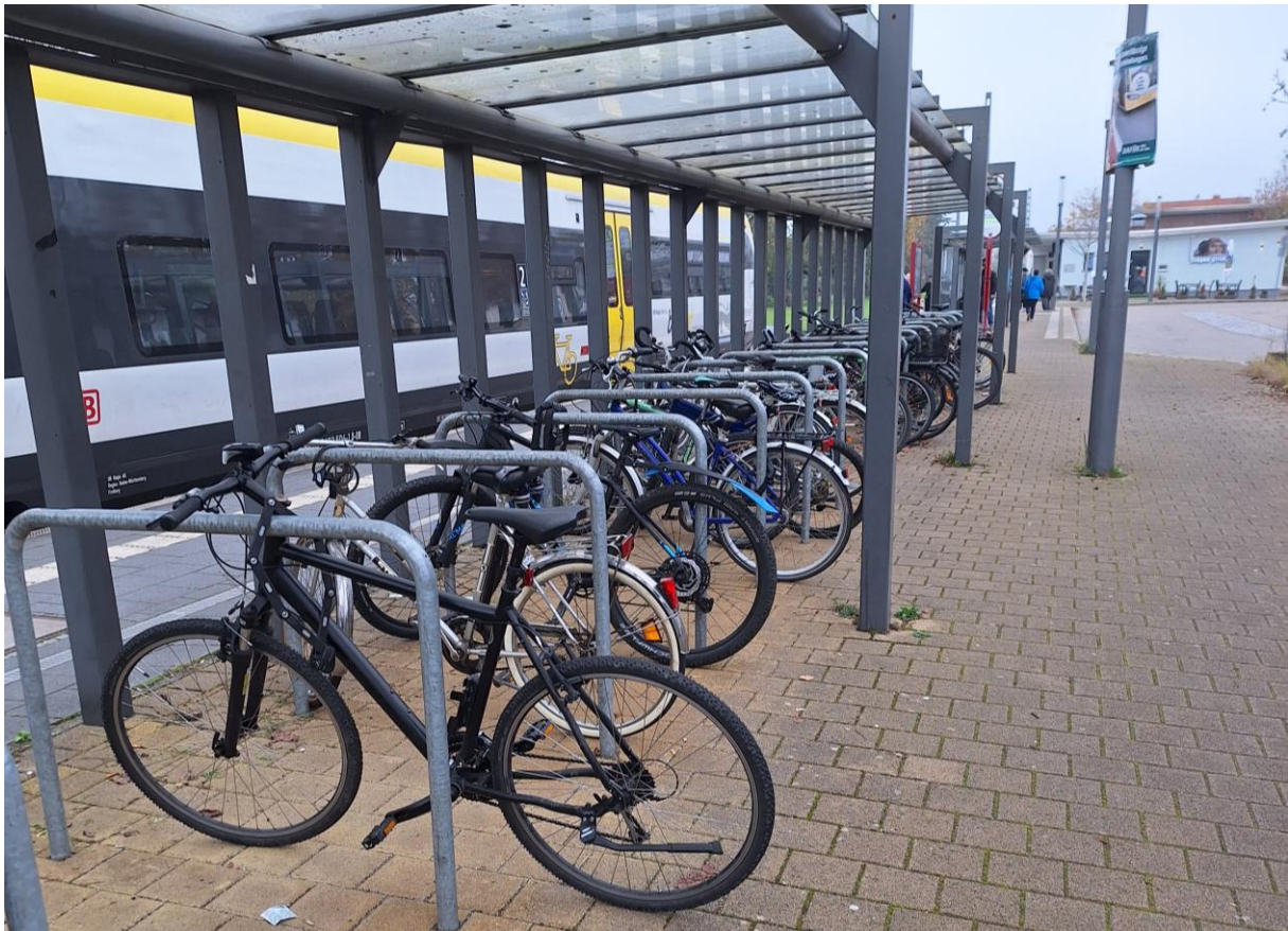
Abbildung 7-6: Einfacher Anlehnhalter mit Rahmenanschlussmöglichkeit am Bahnhof Neuenburg (Baden)
