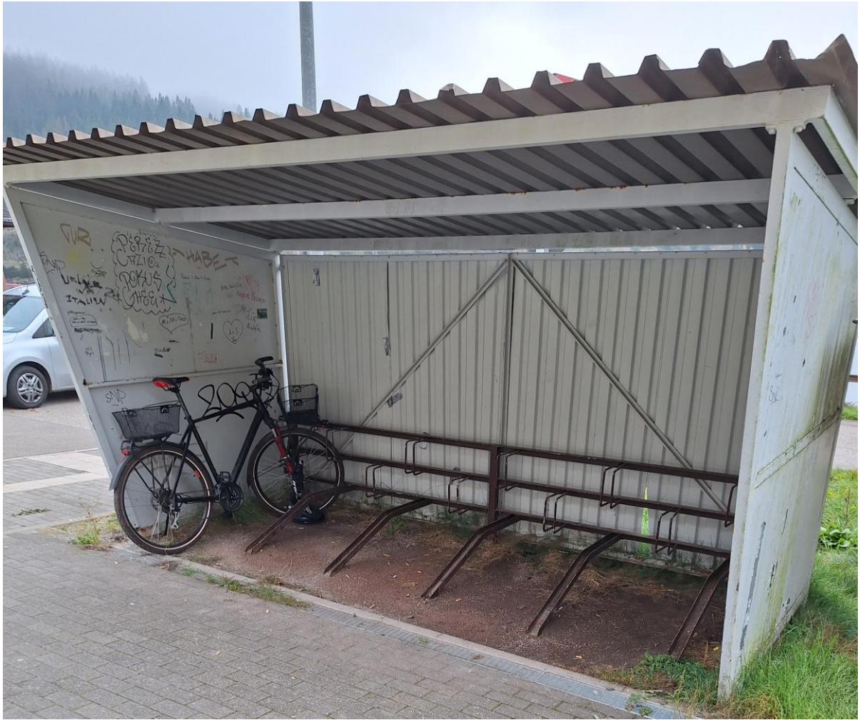
Abbildung 7-5: Beispiele für einfache Vorderradhalter am Bahnhof Seebrugg
